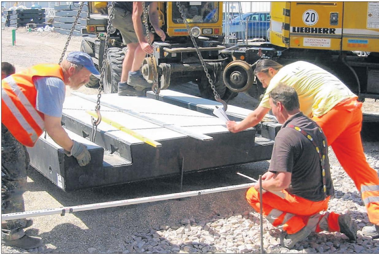
Neue Gleise in wiederverwendbaren Fertigteilplatten werden in der Karlsruher Innenstadt verlegt.
